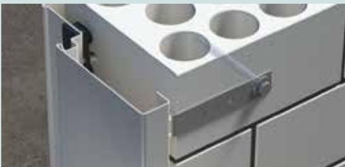
Maueranker gedübelt mit Aufschiebeanker (Mauerwerk / Beton)
