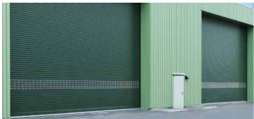
Hallenabschluss in einem Industriebetrieb
